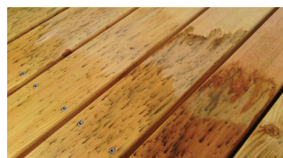
Wasserlösliche Gerbstoffe reagieren bereits beim Kontakt mit minimalen Eisenkonzentrationen. Diese Reaktionen führen zu graublauen bis schwarzen Verfärbungen auf manchen Holzarten.
